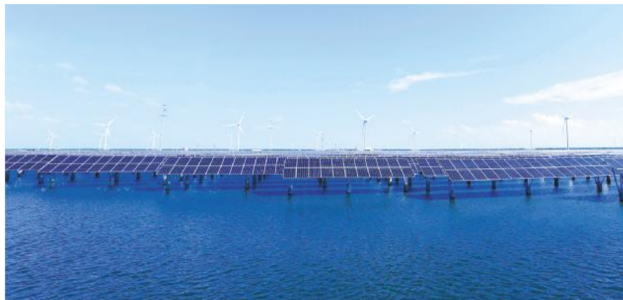
2015年12月30日,通威如东“渔光一体”项目正式实现并网发电,“渔光”变成现实
