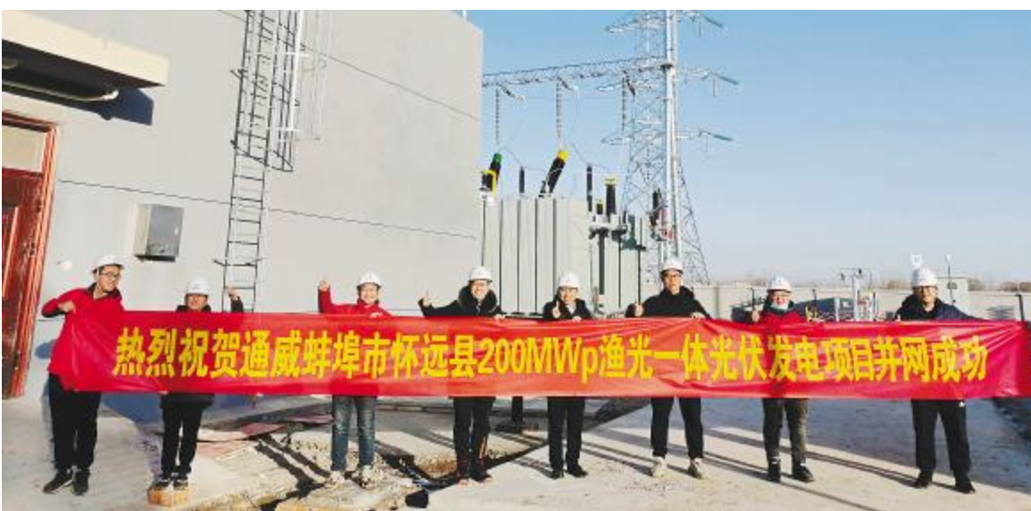
通威蚌埠200MW“渔光一体”光伏发电项目并网成功
