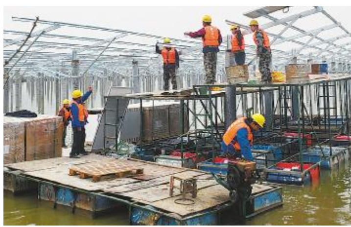
工程建设部扎实推进项目建设
