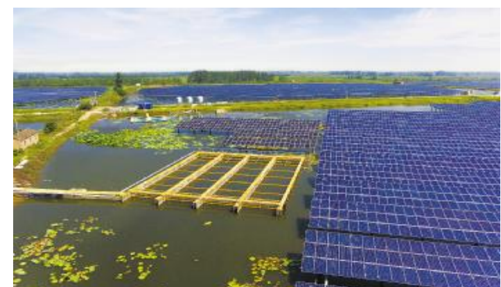
通威和县“渔光一体”基地渔业养殖设施
