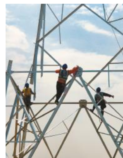
《东营项目组塔作业》
