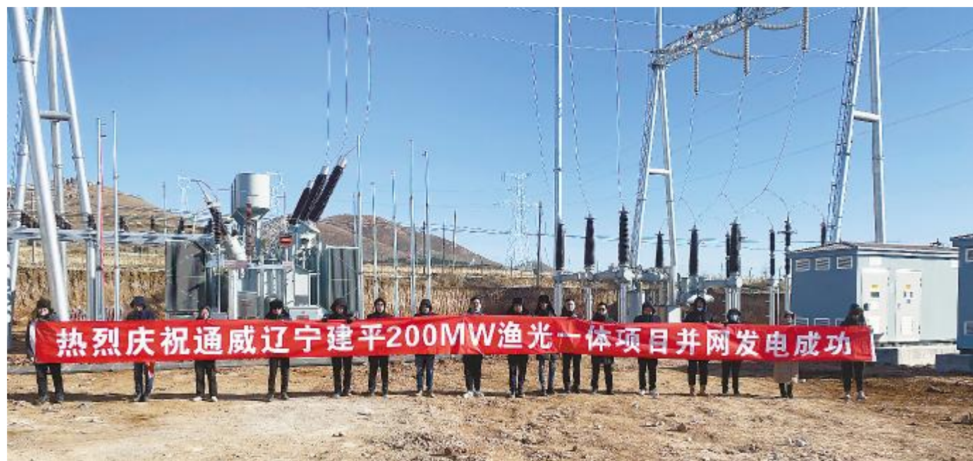
通威建平200MW“渔光一体”光伏项目并网发电成功
