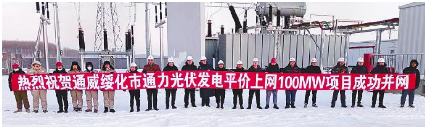
通威绥化“渔光一体”项目成功并网发电
