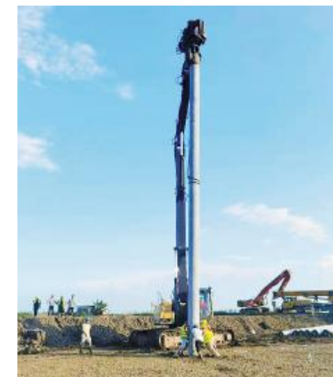
通威天门沉湖首个500MW“渔光小镇”一期项目打下第一根桩
